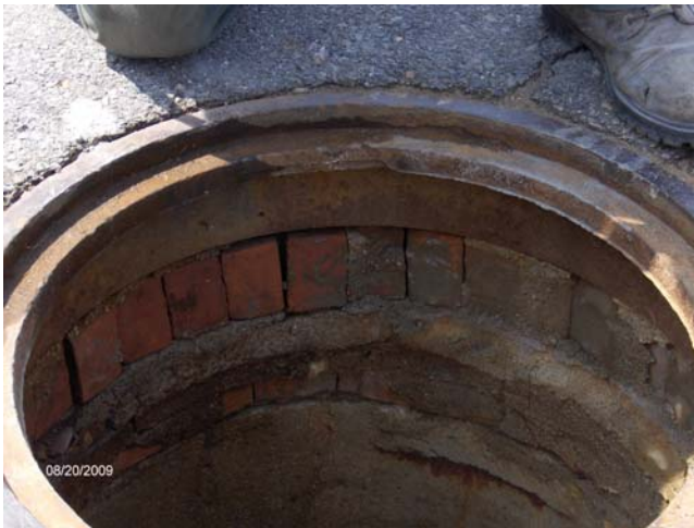
Existing manhole chimney
